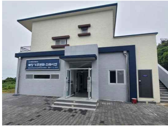
< 스테이션 건물 전경 >
